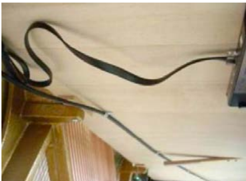
(6) Câble de raccordement au module de commande
