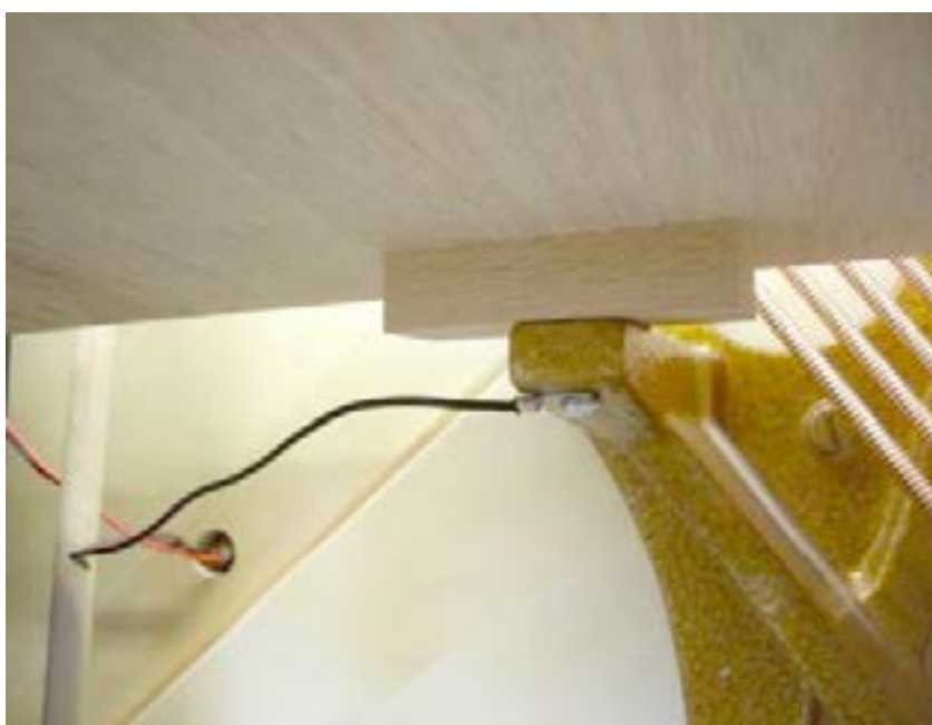
(3) Câble de masse et fixation (éventuellement)
